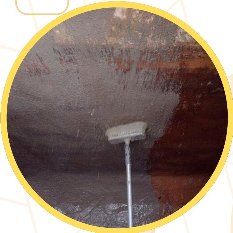
**Impermeabilização do Reservatório com Manta Líquida:** A impermeabilização do reservatório será feita com manta líquida, iniciando pela limpeza e preparo da superfície.
